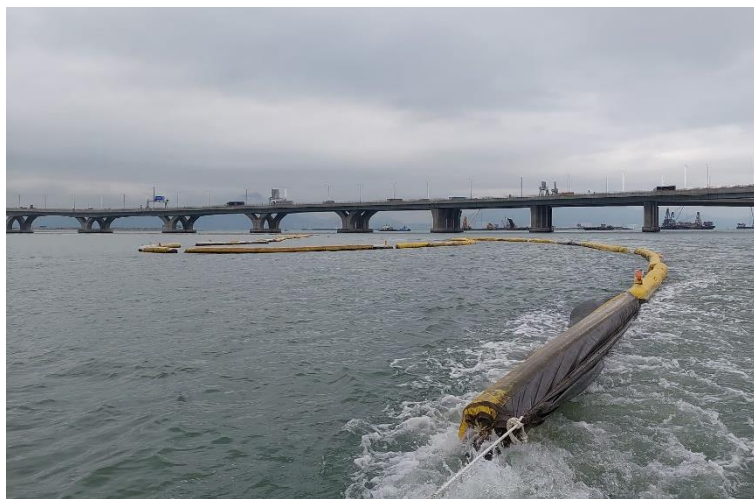
維修及保養淤泥屏障
