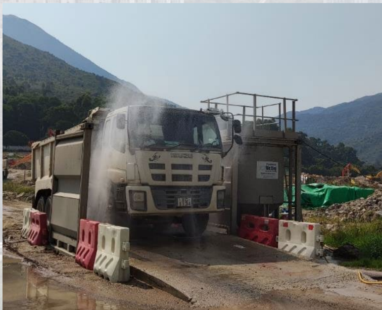
車輛離開地盤需經過洗車設施
